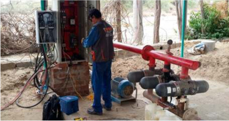
Mantenimiento eléctrico en agroindustrias, mejora de la calidad de la energía eléctrica.
